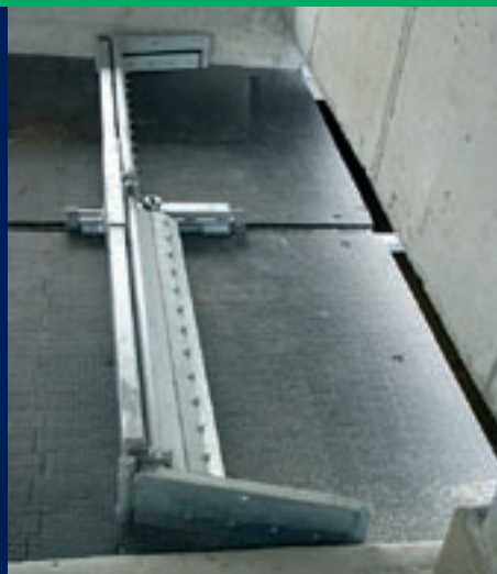
Rubber vloer met JOZ Combischuif. Deze schuiven worden speciaal gemaakt voor een situatie met rubber of beton met ruitmotief.
